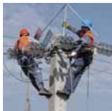
Colocação de dispositivos anti-nidificação
