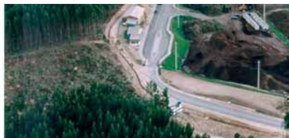
Central de Biomassa de Mortágua
