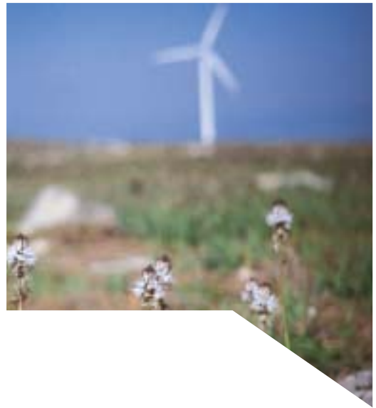
Fonte da Mesa – Aerogenerador.
