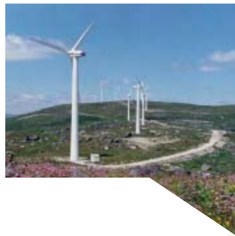
Fonte da Mesa wind farm.
