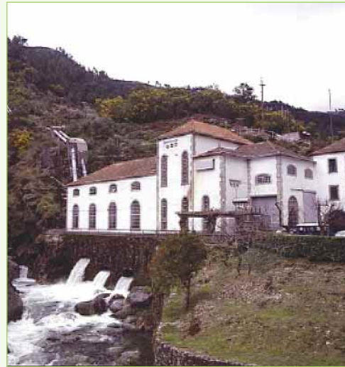
Ponte de Jugais Hydro Power Plant
